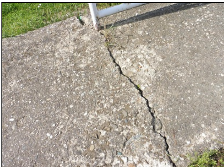
Trhlina v římse.
