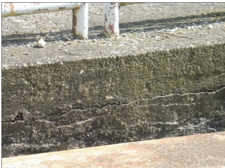
Poruchy na boku římsy.
